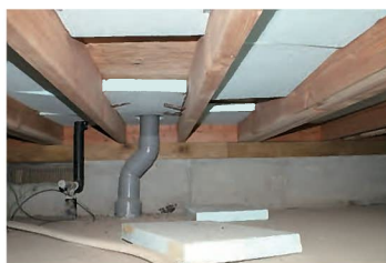
脱落したボード系断熱材
