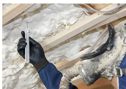
4 施工後チェック
