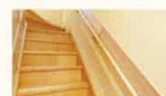
19 赤松無垢階段・無垢階段手すり 階段・手すりもすべて無垢材仕上げ。 工業製品とは触れが異なります。
