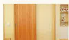
15 木製建具 オリジナル建具 (各戸のレベルはダブルソフトクロス・製作建具)
