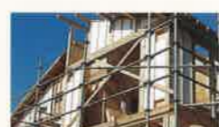
12 アルミ遮熱シート 屋根・壁には遮熱シートを施工。重要しく、省エネルギー。太陽からの赤外線を90%カット。
